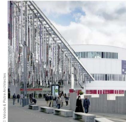
La structure originelle en béton armé de l'ouvrage est mise en valeur et modernisée. Une nouvelle façade vitrée est créée. Grâce à ses vitrages plissés, elle amène un effet d'ondulation à chaque niveau, symbolisant le perpétuel mouvement des expositions et le dynamisme qui anime l'ensemble du parc, tout en offrant aux visiteurs du Pavillon 7 une vue exceptionnelle sur Paris. Il accueille au niveau 7.3 Paris Convention Centre, plus grand centre de congrès d'Europe.
