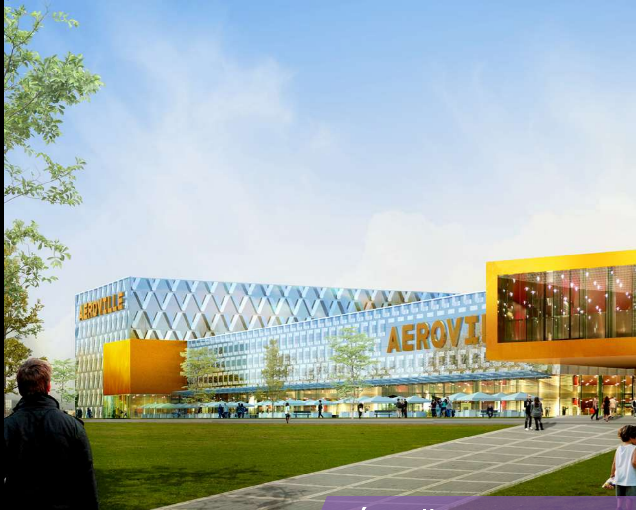
Aéroville, Paris Region
